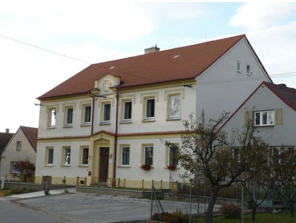
Obr. 12: Fotografie z roku 2007, nová plastová okna, před budovou vybudována parkovací místa, v přízemí obecní byt (okna s muškáty)
