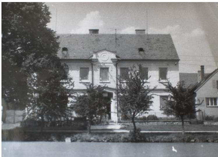
Obr. 18: Budova v roce 1977, kromě nových oken je zde také vidět chybějící křížek nad průčelím
